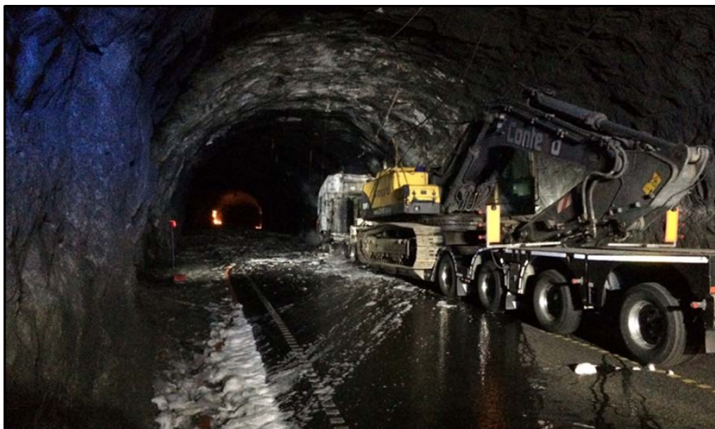
Figur 2: Sluttposisjon vogntog inklusiv skader på kjøretøyer og tunnelen. Foto: Eidfjord brannvern
