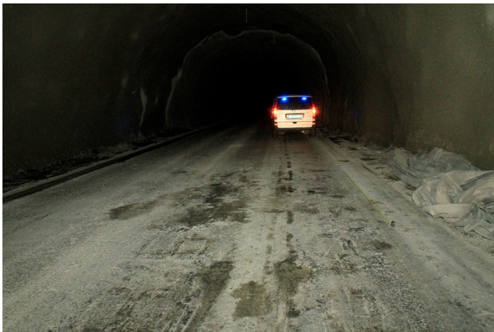
Figur 9: Merker i vegbanen (ved sluttposisjonen) fra hjul på lastebilen og smeltet nedfall fra infrastruktur og vogntoget. Foto: Kripas
