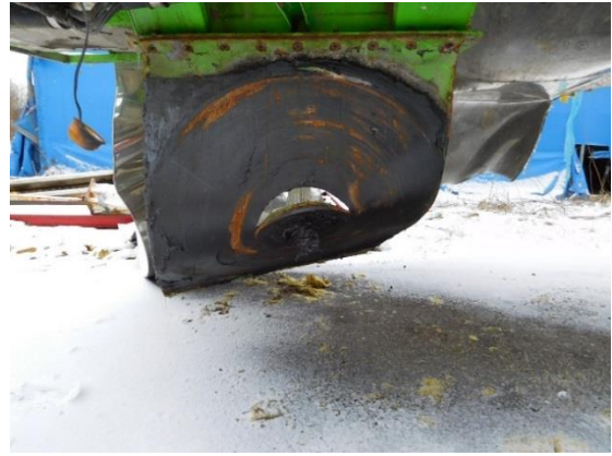
Figur 4: Kingpinplaten sett fra venstre. Foto: Statens vegvesen
