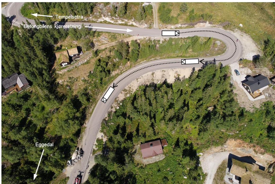
Figur 2: Skisse av hendelsesforløpet. Foto: Statens vegvesen. Illustrasjon: SHT
