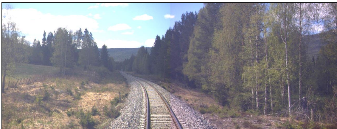
Figur 19: Kurven før planovergangene. Km 261,813. Foto: Bane NOR Målevognbilder
