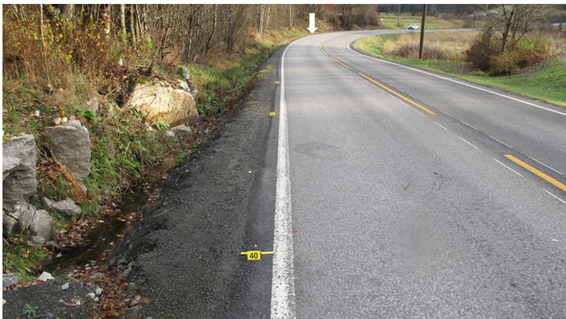
Figur 6: Ulykkesstedet, sett mot brannbilens kjøreretning. Bildet er tatt 30. november 2019, etter at grøftekanten var gruset opp etter ulykken. Hvit pil markerer stedet der brannbilen kjørte utenfor veibanen. Markeringsskilt nr. 40 markerer brannbilens sluttposisjon, som var der grøften går over i en stikkrenne. Foto: SHT
