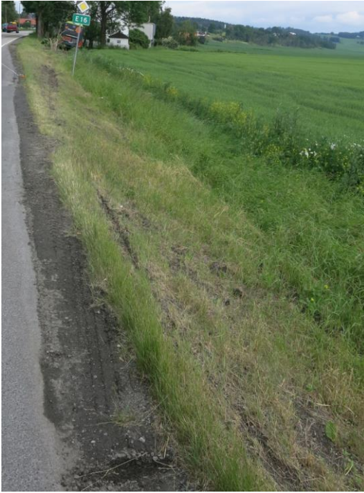
Figur 3: Sporavsetning som viser dekkmønster fra bussens høyre hjulsett. Foto: SHK
