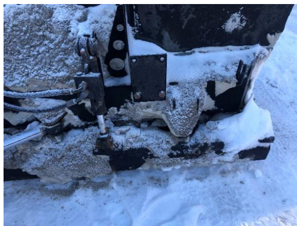
Figur 28: Nedfellbare slapse-lameller montert i bakkant langs skjæret. Foto: SHK
