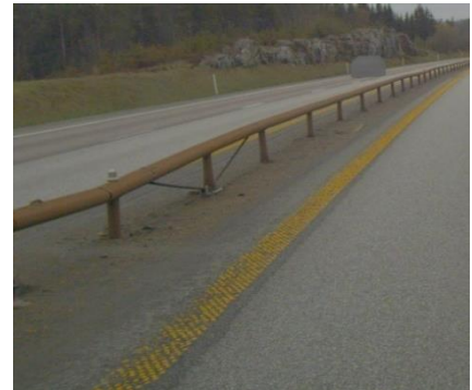
Figur 27: Sørligste del av nød-/driftsåpningen 11. mai 2021. Foto: Vegbilder.no
