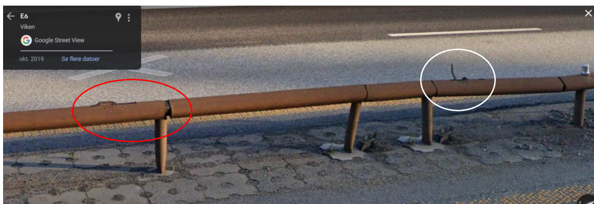
Figur 24: Låsehåndtak i åpen posisjon, se hvit ring. Glippe med låsehåndtak i lukket posisjon, se rød ring. Bilde: Googlemaps. Illustrasjon: SHK
