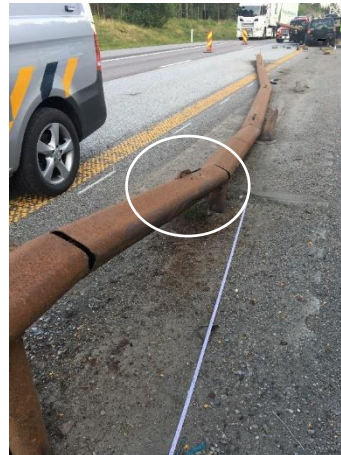
Figur 6: En skjøt med låseanordning (hvit ring). Foto: Politiet. Illustrasjon: SHK
