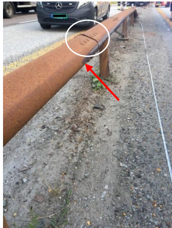
Figur 5: Bilens første kontaktpunkt med rekkverket (rød pil), ved en boltet skjøt, se hvit ring. Foto: Politiet. Illustrasjon SHK
