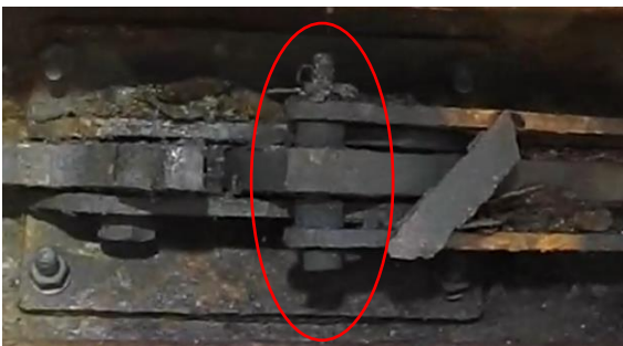
Figur 31: Nærbilde av boltforbindelsen fra figur 29 viser bolt med splint og hylser, se rød ring. Foto og illustrasjon: SHK
