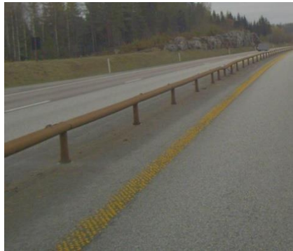
Figur 26: Midtre del av nød-/driftsåpningen 11. mai 2021. Foto: Vegbilder.no
