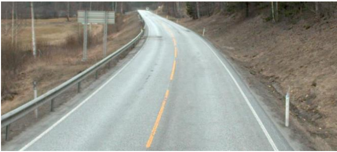
Figur 41: Sigma-rekkverk, kantstolper, sideterrang, midtlinje og kantlinjer. Kilde: Vegbilder.no
