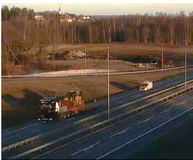
Figur 3: Kl. 20:03:36 i krysset E6/Rv222 nord for Hamar (E6N0743). Foto: VTS
