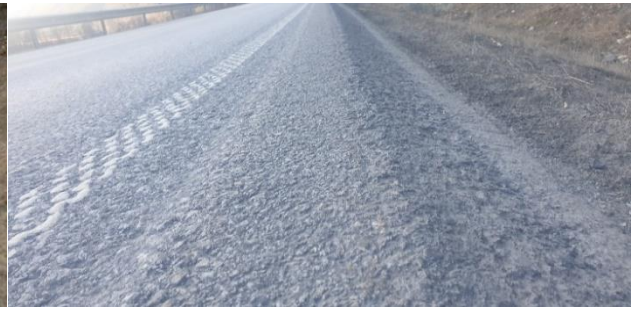
Figur 42: Detalj av dråpeflex kantlinje, fresing og skråkant mot grøft. Kilde: Statens vegvesen
