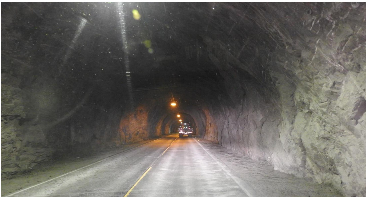
Figur 19: Bakkant av tilhengar plassert midt mellom to lysarmaturar (mørk sone), 45 meter framfor personbilen, utan lys på traktor og tilhengar. Fjernlys på personbilen. Foto: SHK
