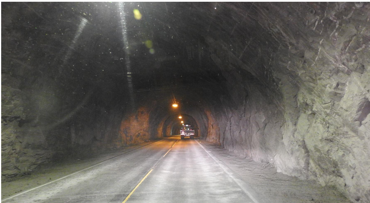
Figur 41: Bakkant av tilhenger plassert midt mellom to lysarmaturer (mørk sone), 45 meter framfor personbilen, utan lys på traktor og tilhenger. Fjernlys på personbilen. Det var armatur med kvitt lys rett framfor bilen. Foto: SHK
