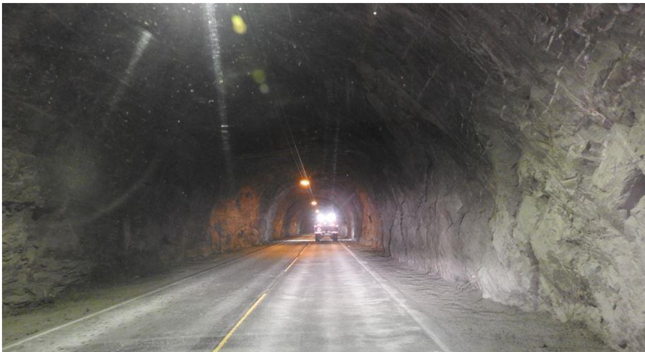
Figur 33: Bakkant av tilhenger plassert midt mellom to lysarmaturer (mørk sone), 45 meter framfor personbilen, bak- og arbeidslys bak på traktor. Ikkje lys på tilhenger. Fjernlys på personbilen. Det var armatur med kvitt lys rett framfor bilen. Foto: SHK
