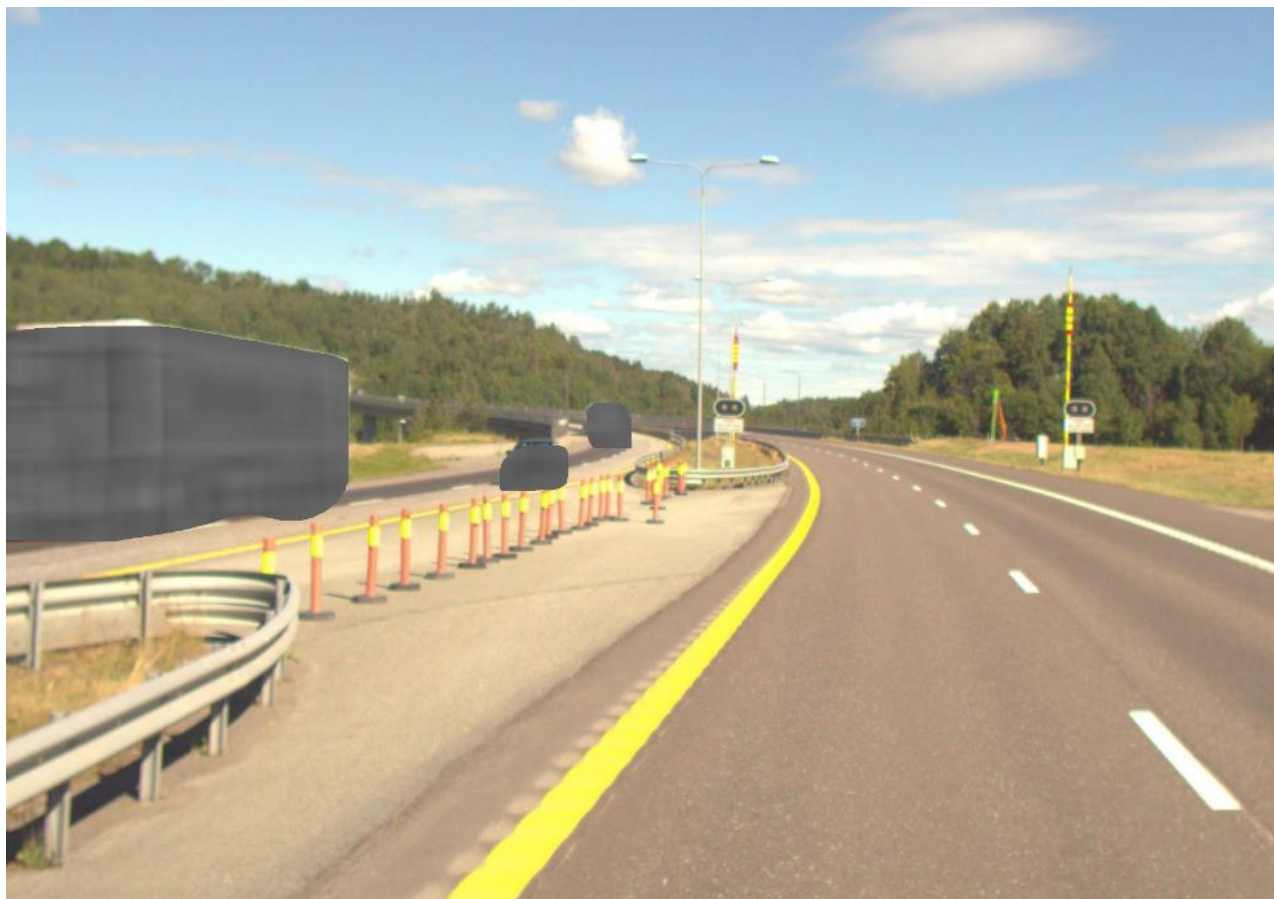
Figur 17: Driftsåpningen ved ulykkesstedet. Bildet er tatt 5. juli 2022. Foto: Statens vegvesen, Vegbilder
