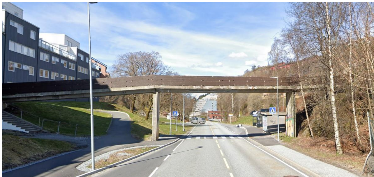
Figur 16: Skjenlia gangbru sett frå sør før ulykka hende. Kjelde: Google Street View (april 2023).
