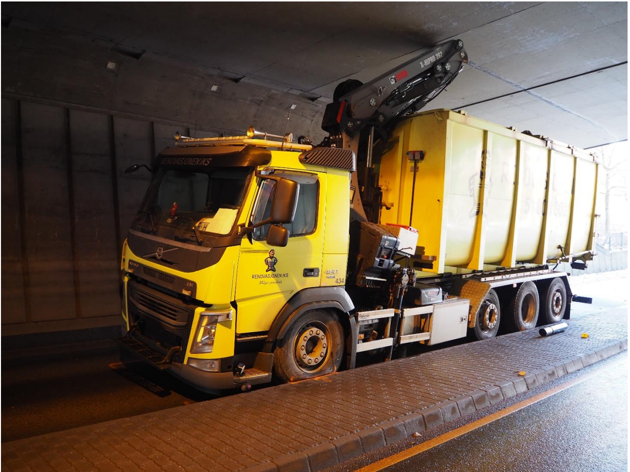
Figur 23: Ulykkesstaden i Stavanger 9. mars 2023. Renovasjonsbilen stansa etter at krana trefte taket på kulverten. Foto: Statens vegvesen
