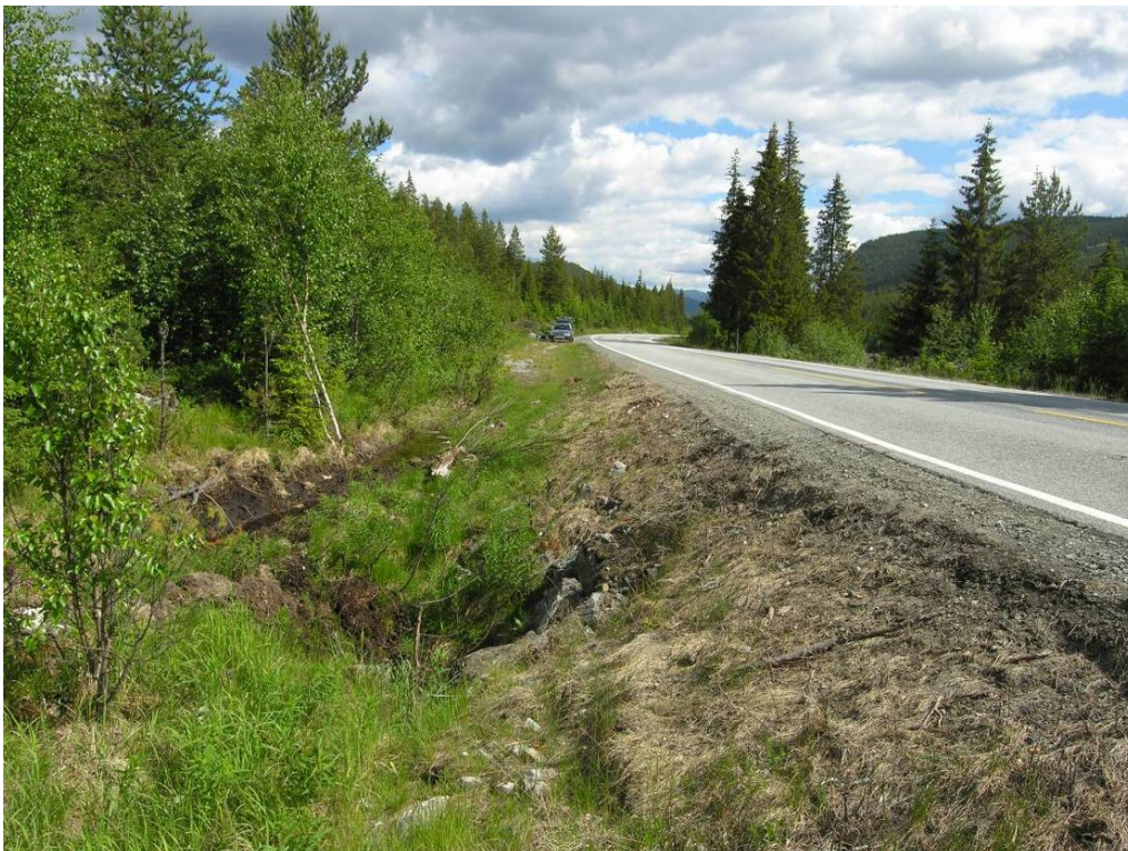
Fig. 10: Stikkrennen/grøften personbilen havnet i, sett i personbilens kjøretning mot Robru (foto tatt 28. juni 2006).
