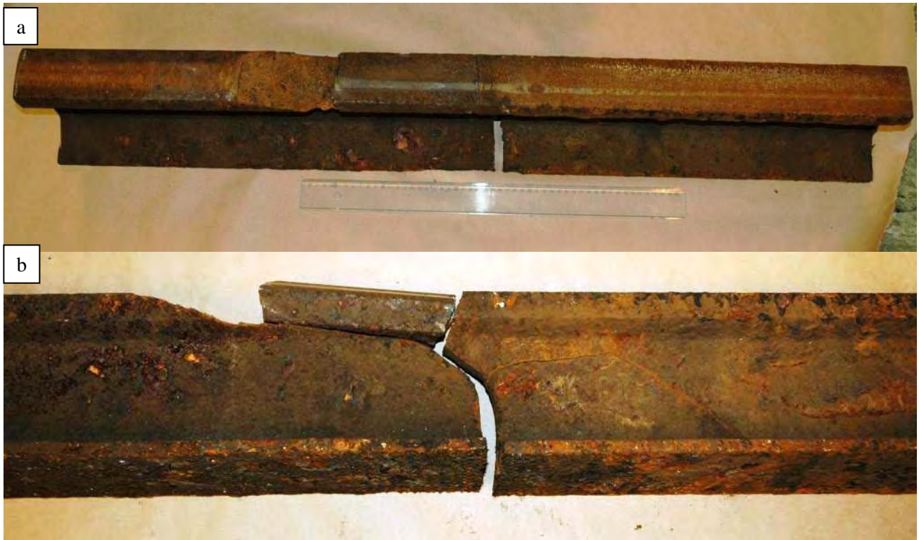
Figur 1ab: Bilder av jernbaneskinne som mottatt for skadeundersøkelse.
