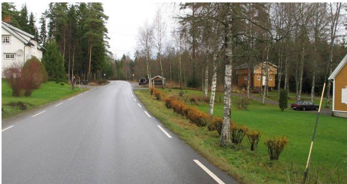
Figur 18: Nedklippet hekk i sikktrekanten ved ulykkesstedet (foto: Statens vegvesen)
