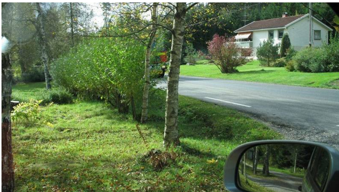
Figur 9: Siktforholdene til venstre på Rv 123 fra privatveien på Krogstadfossen på ulykkesdagen. Bak hekken skimtes en lastebil (fra Statens vegvesens rekonstruksjon).
