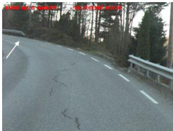
Figur 19: Oppholdet i rekkverket i kurven vest for ulykkespunktet. Bildet er tatt etter tiltaket fra TS-inspeksjonen, og før ulykken. Pilen markerer stedet der rekkverket avsluttes mot steinene.
